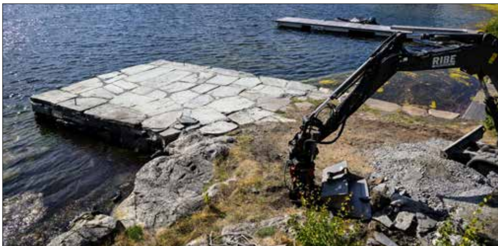
Arbeidene er utført av et lokalt selskap, Ribe Entreprenør.
